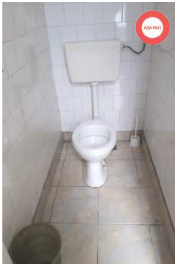
Figură 20 Așa nu! Cabină WC dată în folosință fără port hârtie igienică, fără colac. Echipamente și instalații de calitate nerecomandată.
