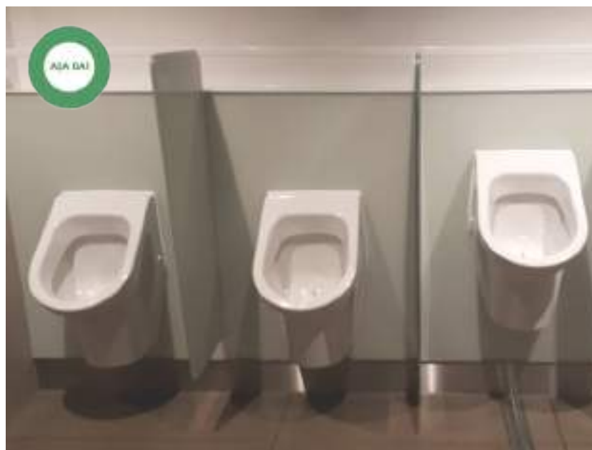
Figură 98 Așa da! Pisoare amplasate la distanțe corecte, separate cu accesorii de separare înalte. Pisoarele sunt poziționate la niveluri diferite, pentru utilizarea diferențiată pe grupe de vârstă.
