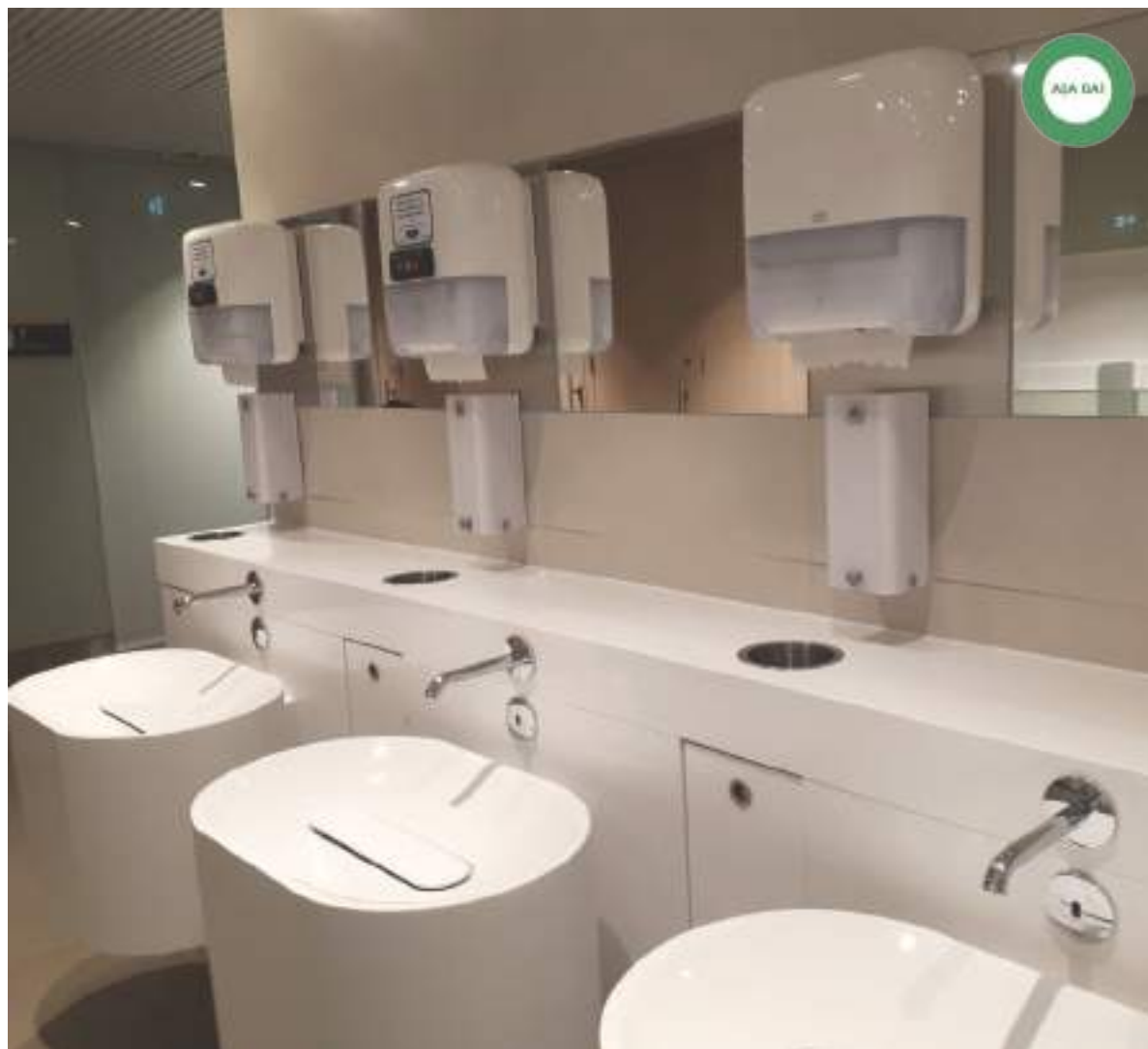
Figură 49 Așa da! Grupuri sanitare cu lavoare care înglobează sifoanele de scurgere, baterii și dispenser de săpun cu celulă. Rezolvare frumoasă și elegantă a spațiului, cu posibilitatea curățării și dezinfectării eficiente a acestuia.
