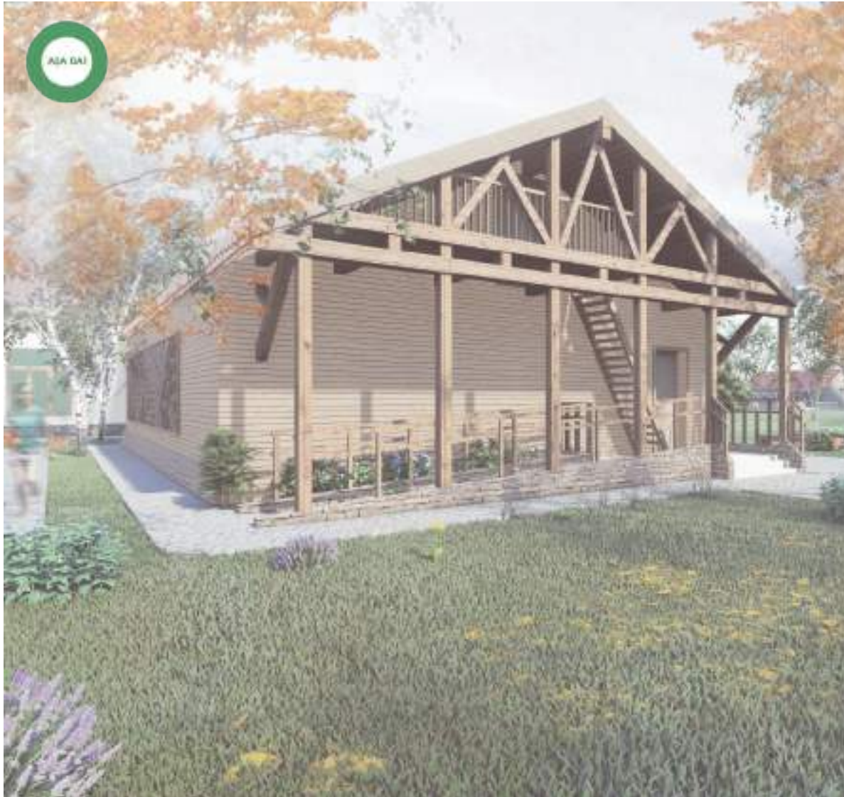
Figură 17 Așa da! Extindere a școlii rezolvată cu structură din lemn, în zonele în care lemnul din surse regenerabile este o resursă accesibilă.
