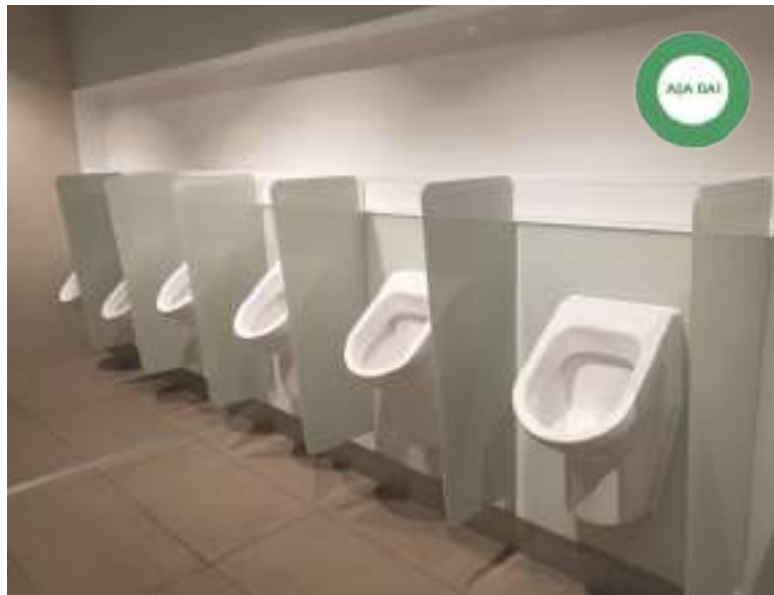
Figură 31 Așa da! Pisoare montate cu separatoare pentru asigurarea intimității, evitarea stropirii și a circulației mirosurilor neplăcute.
