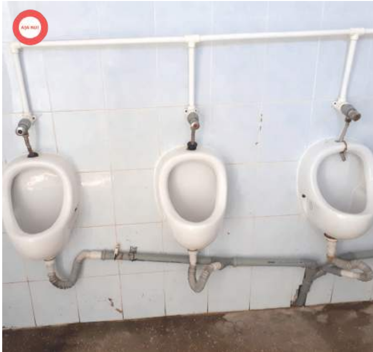
Figură 23 Așa nu! Instalații noi, aparente, montaj precar, funcționare defectuoasă, lipsă de igienă.
