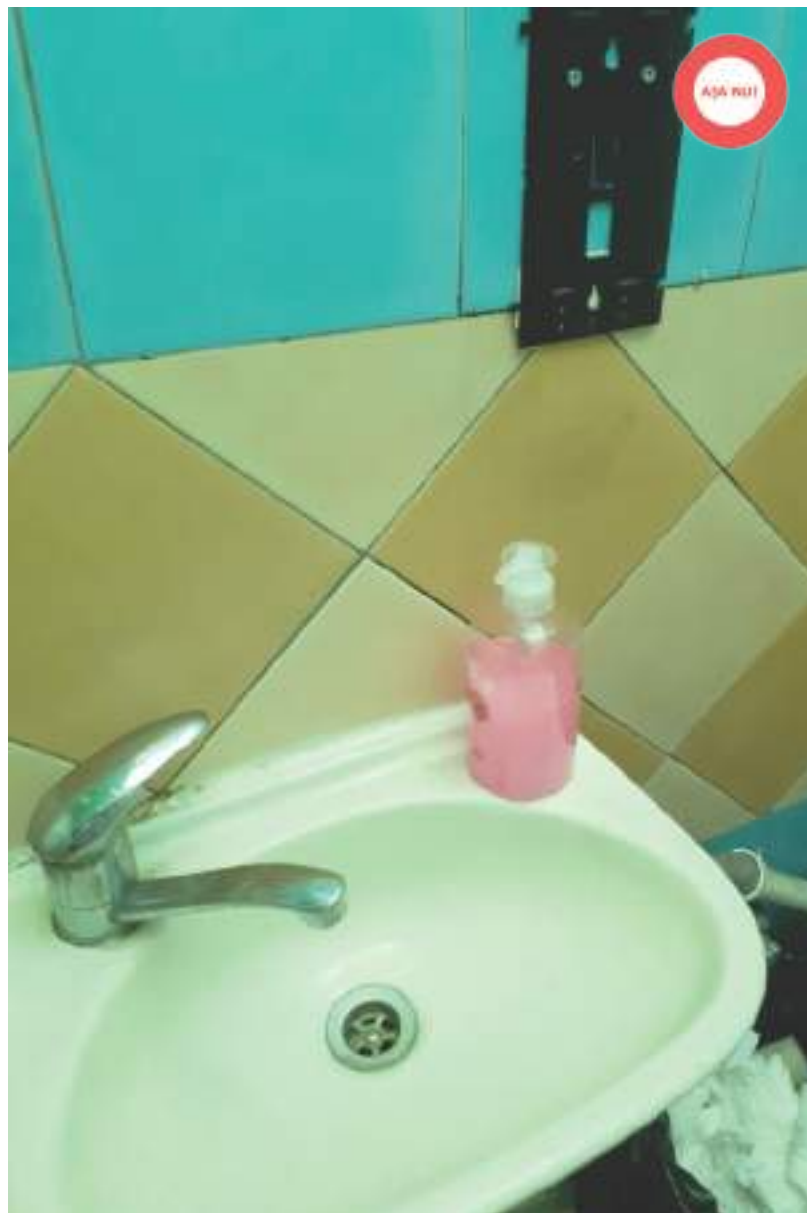
Figură 38 Așa nu! Alcătuiți precare, neadecvate. Lavoar greșit ales, baterie de calitate scăzută, instalații pozate aparent, dispenser săpun stricat. Coș de gunoi plin, întreținere proastă.
