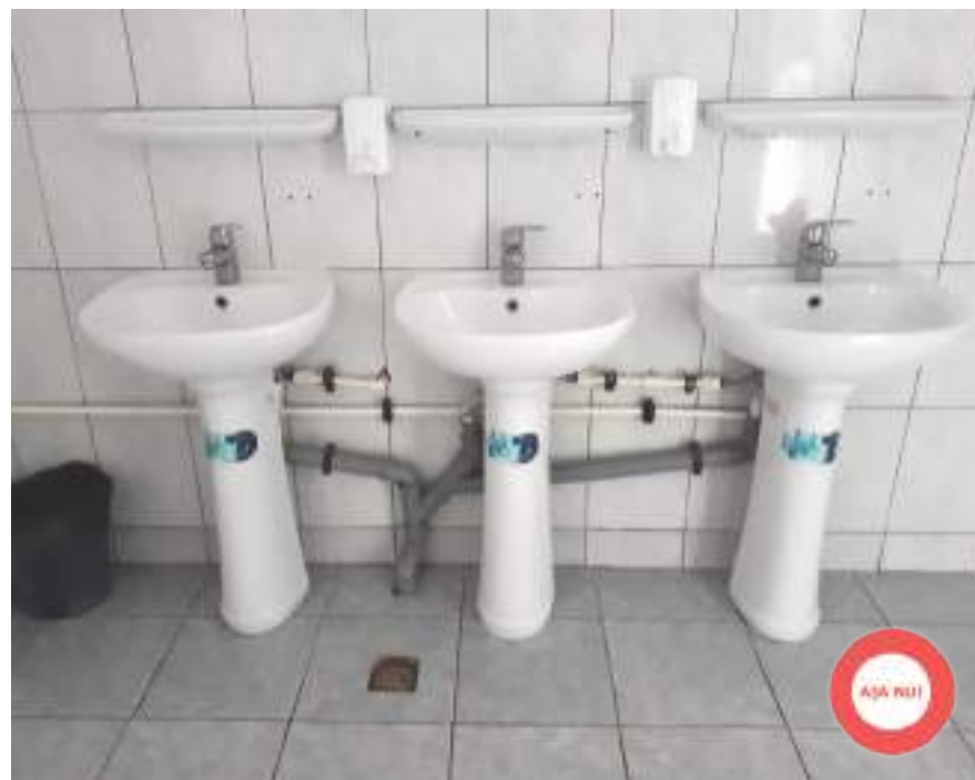
Figură 102 Așa nu! Ambianță negândită. Imagine dezastruoasă, obținută prin pozarea alimentării cu apă și canalizărilor pe pereți. Polițele au fost montate la o cotă înaltă, care face inutilă plasarea unor oglinzi deasupra lor, întrucât acestea ar reflecta tavanul.
