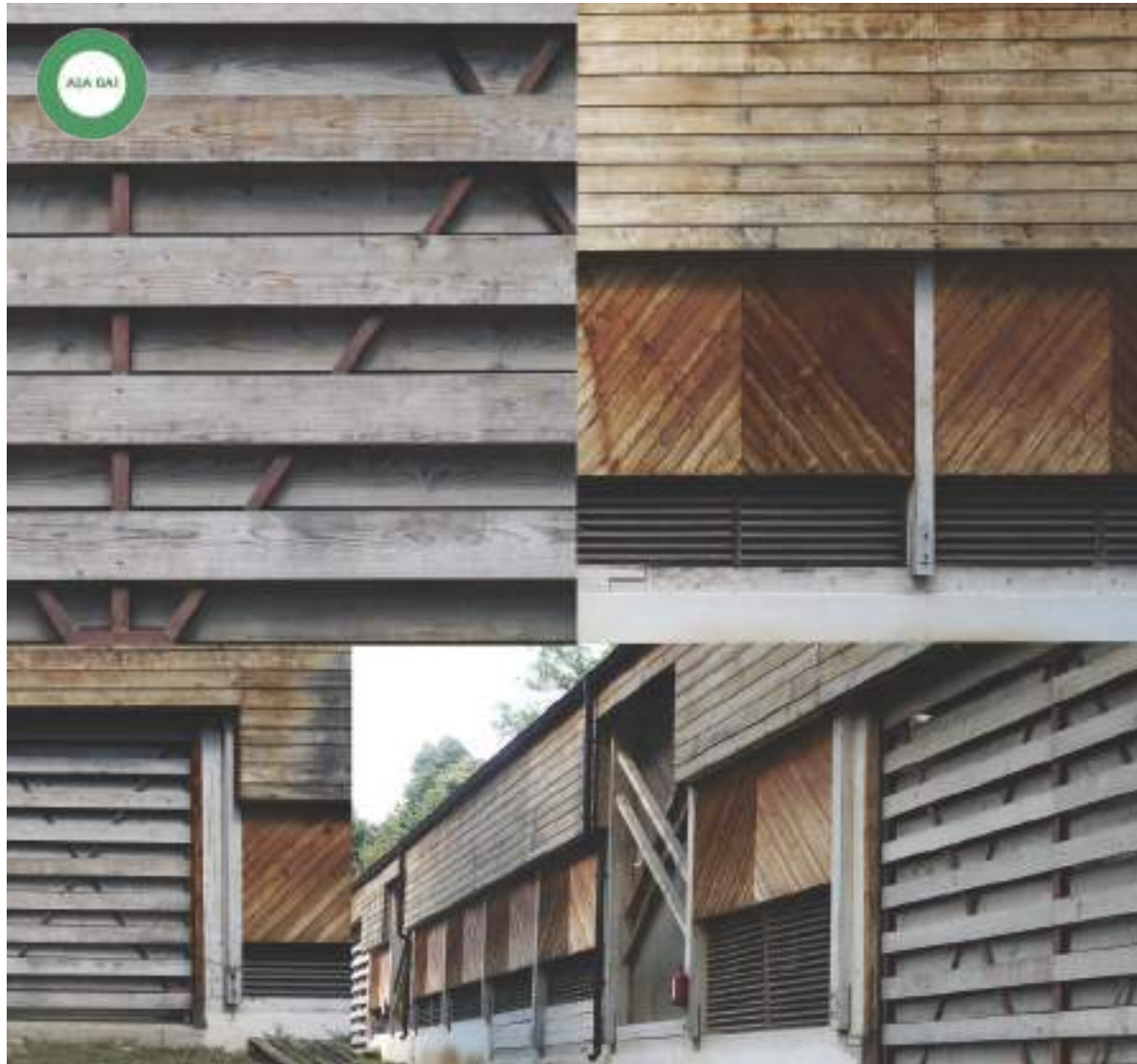
Figură 53 Așa dal. Pereți exteriori executați cu materiale locale în alcătuiți contemporane.
