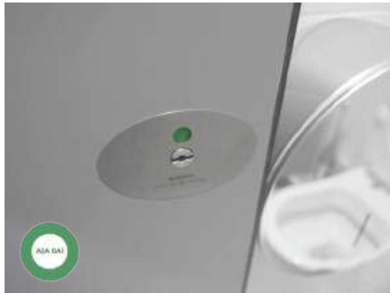
Figură 15 Așa da! Uși la cabine WC echipate cu zăvor metalic, acționabil doar din interior, care indică ocuparea cabinei.
