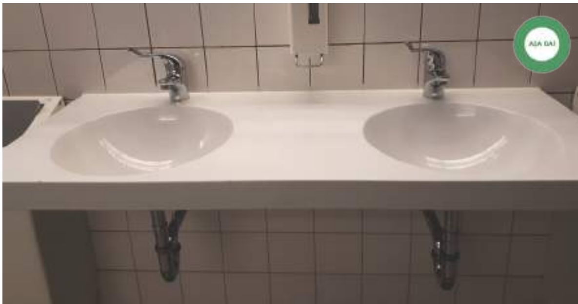
Figură 97 Așa da! Instalații de bună calitate, din oțel, asigurând o etanșeitate perfectă. Se evită, astfel, mirosurile neplăcute din grupul sanitar.
