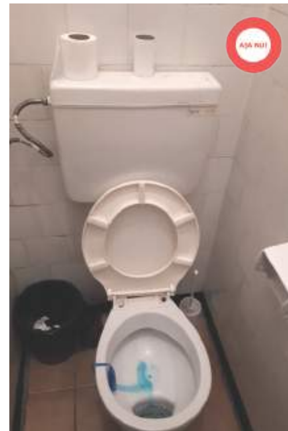
Figură 19 Așa nu! Cabină WC modernizată parțial, lipsită de igienă. Echipamente și instalații de calitate nerecomandată.
