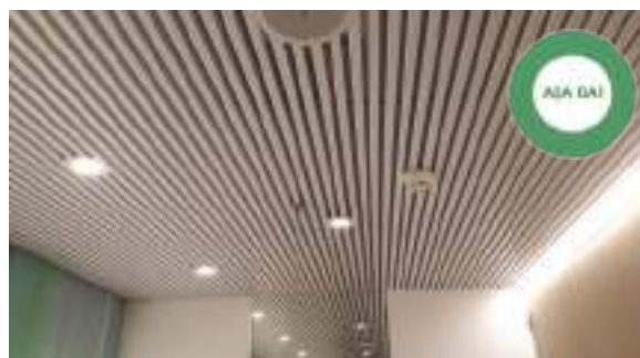
Figură 93 Așa da! Tavanele lamelare au bune proprietăți fonoabsorbante și sunt recomandate la grupurile sanitare.
