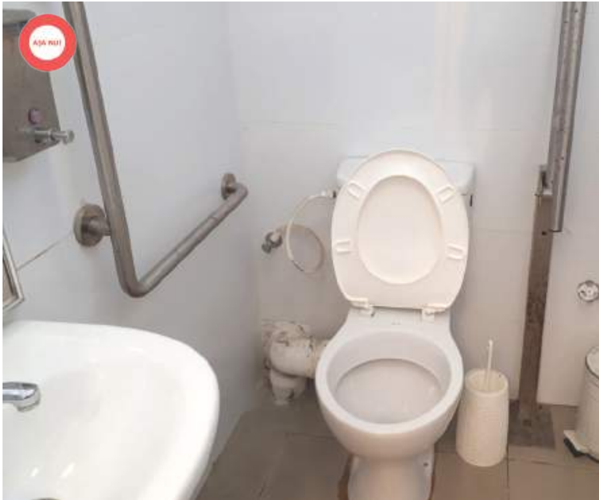
Figură 10 Așa nu! Grup sanitar pentru persoane cu dizabilități, murdar, deteriorat și imposibil de folosit corespunzător. Dispenserul de hârtie igienică nu poate fi atins. Dispenserul de săpun este amplasat prea sus.
