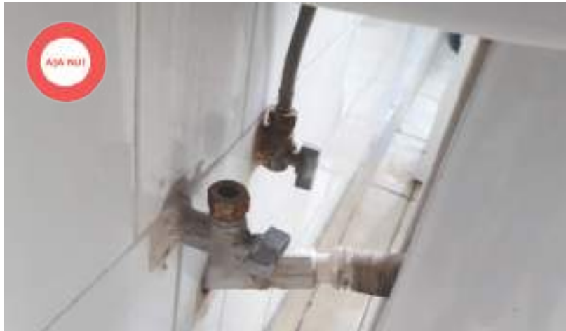
Figură 96 Așa nu! Instalațiile lipsite de durabilitate vor genera pierderi de lichide urât mirositoare.
