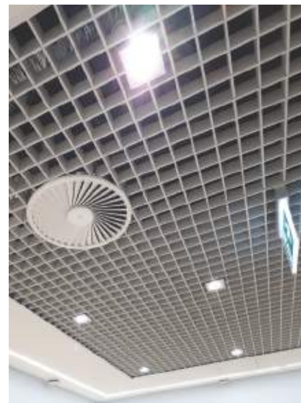
Figură 107 Detaliu de execuție plafon suspendat din lamele perpendiculare. Se observă pozarea grilei de aer, lămpilor pentru iluminatul general și cel de urgență. Deasupra plafonului sunt amplasate tubulaturile de ventilație, în vederea extracției aerului viciat.
