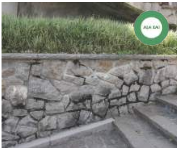
Figură 51 Așa da! Relație soclu-trotuar-trepte, rezolvată cu piatră de calitate și textură diferită.
