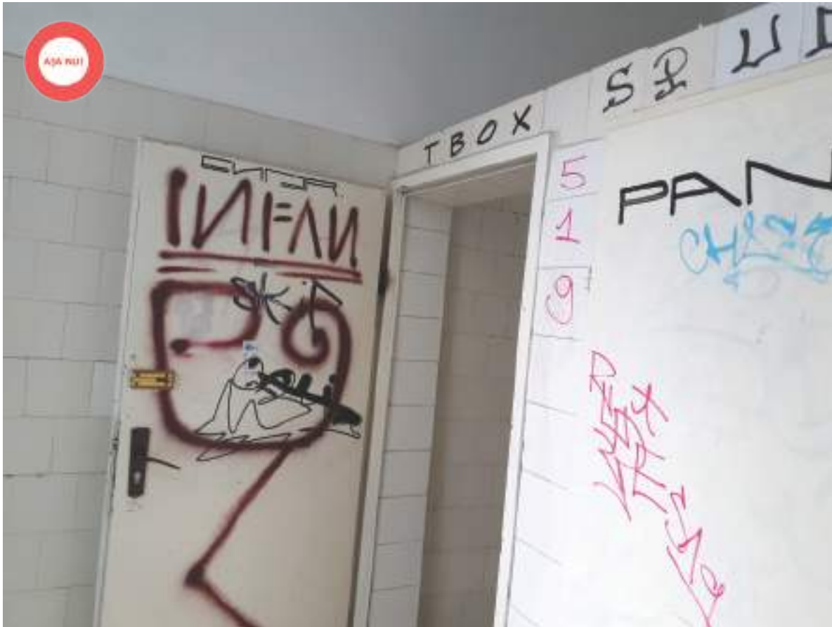
Figură 27 Așa nu! Grup sanitar vandalizat, cu înălțime liberă mare deasupra pereților despărțitori. Odată cu distribuția pe scară largă a mijloacelor de filmare, astfel de conformări au ajuns să fie speculate în vederea înregistrării și, ulterior, șantajării și umilirii elevilor.
