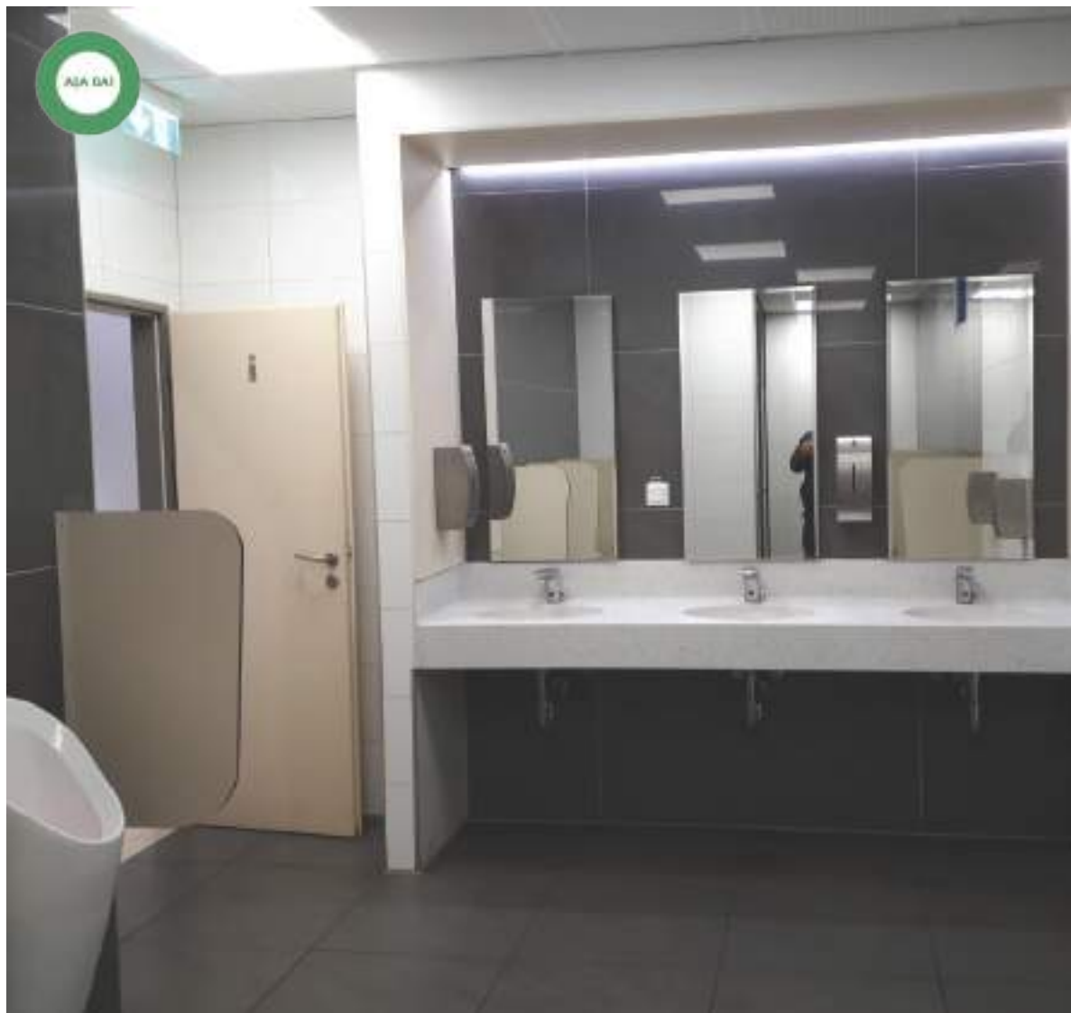
Figură 59 Așa da! Finisaje interioare: gresie porțelanată, faianță, vopsitorii pe bază de acril sau latex, plafoane fonoabsorbante din gipscarton.
