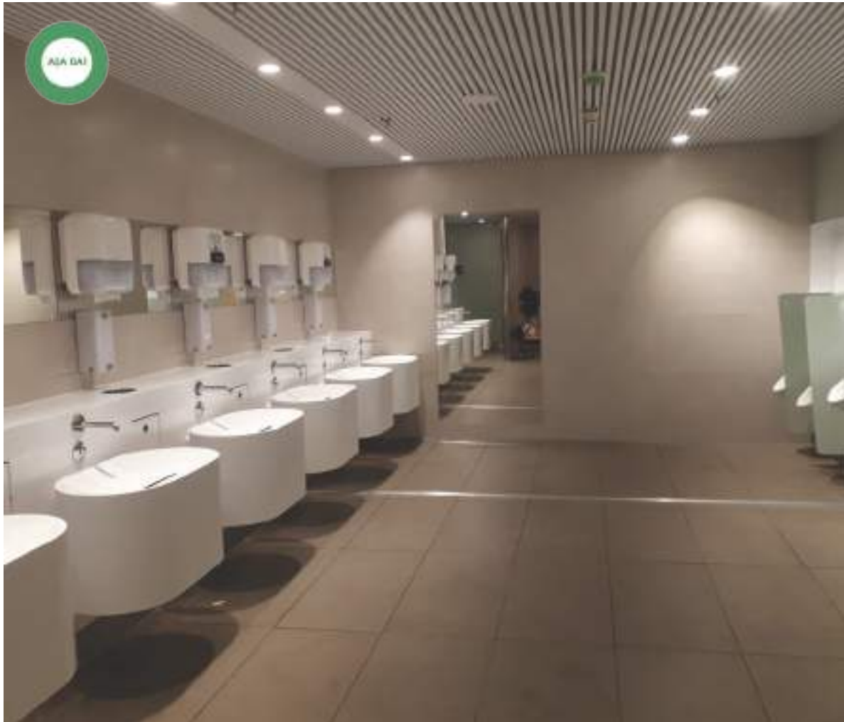
Figură 62 Dispenserele de săpun se vor monta astfel încât să fie ușor de ajuns cu mâna, iar picătura de săpun să poată să cadă în lavoar. Prosoapele de hârtie trebuie să poată fi ușor accesibile, fără a traversa încăperea cu mâinile ude, pentru a le putea șterge. Coșul de gunoi trebuie amplasat în vecinătatea suportului cu prosoape de hârtie. Pisoarele trebuie prevăzute cu panouri pentru protejarea intimității.
