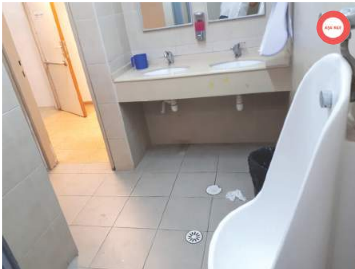
Figură 4 Așa nu! Eroare de proiectare. În cazul deschiderii ușii, care separă grupul sanitar bărbați de holul instituției, pisoarul poate fi văzut de oricine tranzitează coridorul în acel moment.
