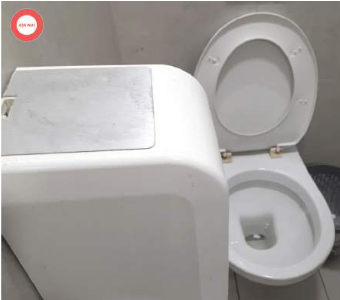
Figură 3 Așa nu! Eroare de proiectare. Nu s-a ținut cont de prezența dispenserului de hârtie igienică la dimensionarea cabinei WC. După montarea acestuia, spațiul a devenit insuficient.
