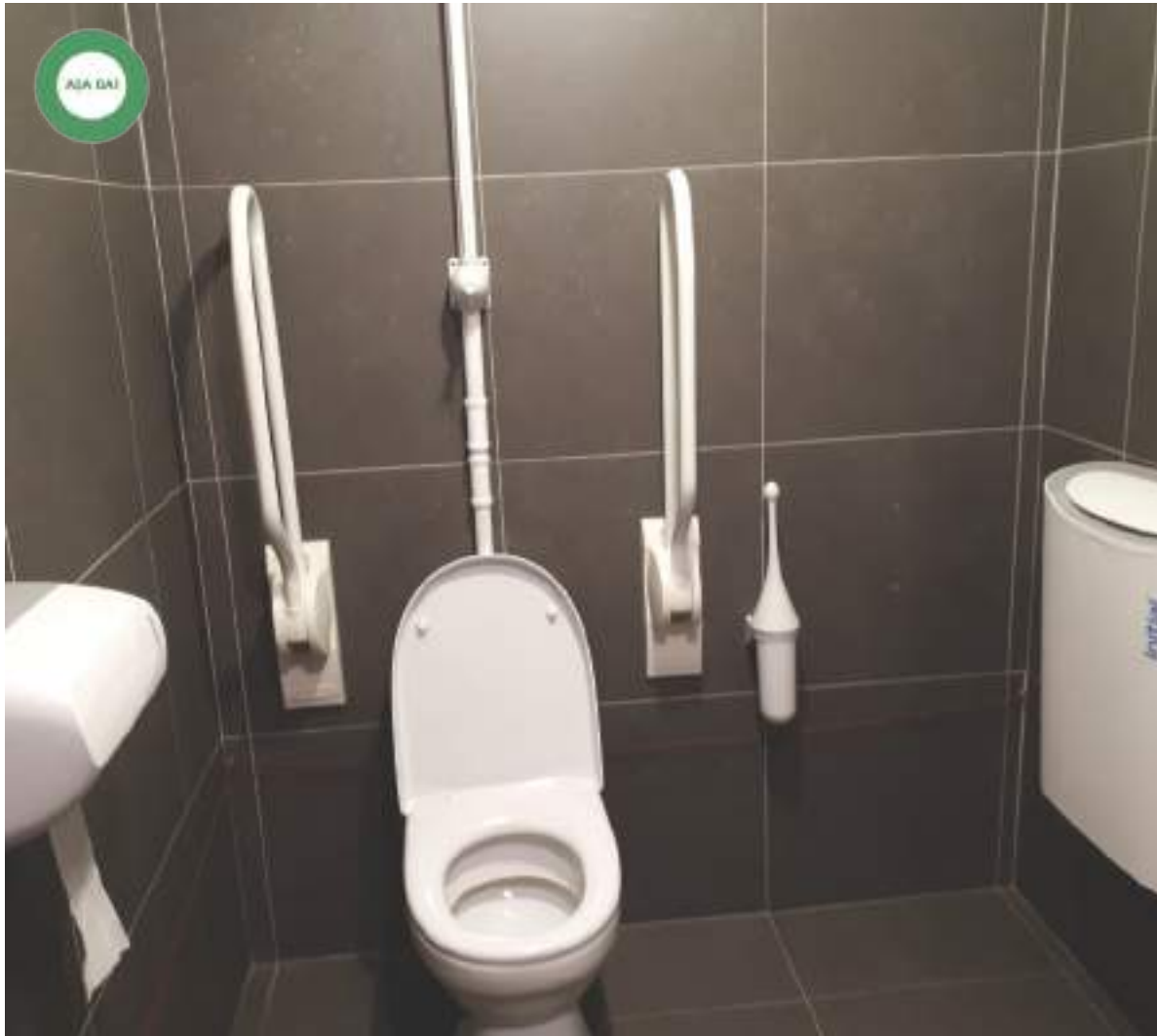
Figură 35 Așa da! Rezolvare corectă a grupului sanitar pentru persoane cu dizabilități locomotorii. Amplasarea accesoriilor și obiectelor sanitare este la îndemână, sunt respectate distanțele și configurațiile prevăzute în normativ. În plus, grupul sanitar este echipat și cu fir roșu perimetral care, în cazul prăbușirii, poate fi agățat cu mâna pentru a semnaliza starea de urgență.
