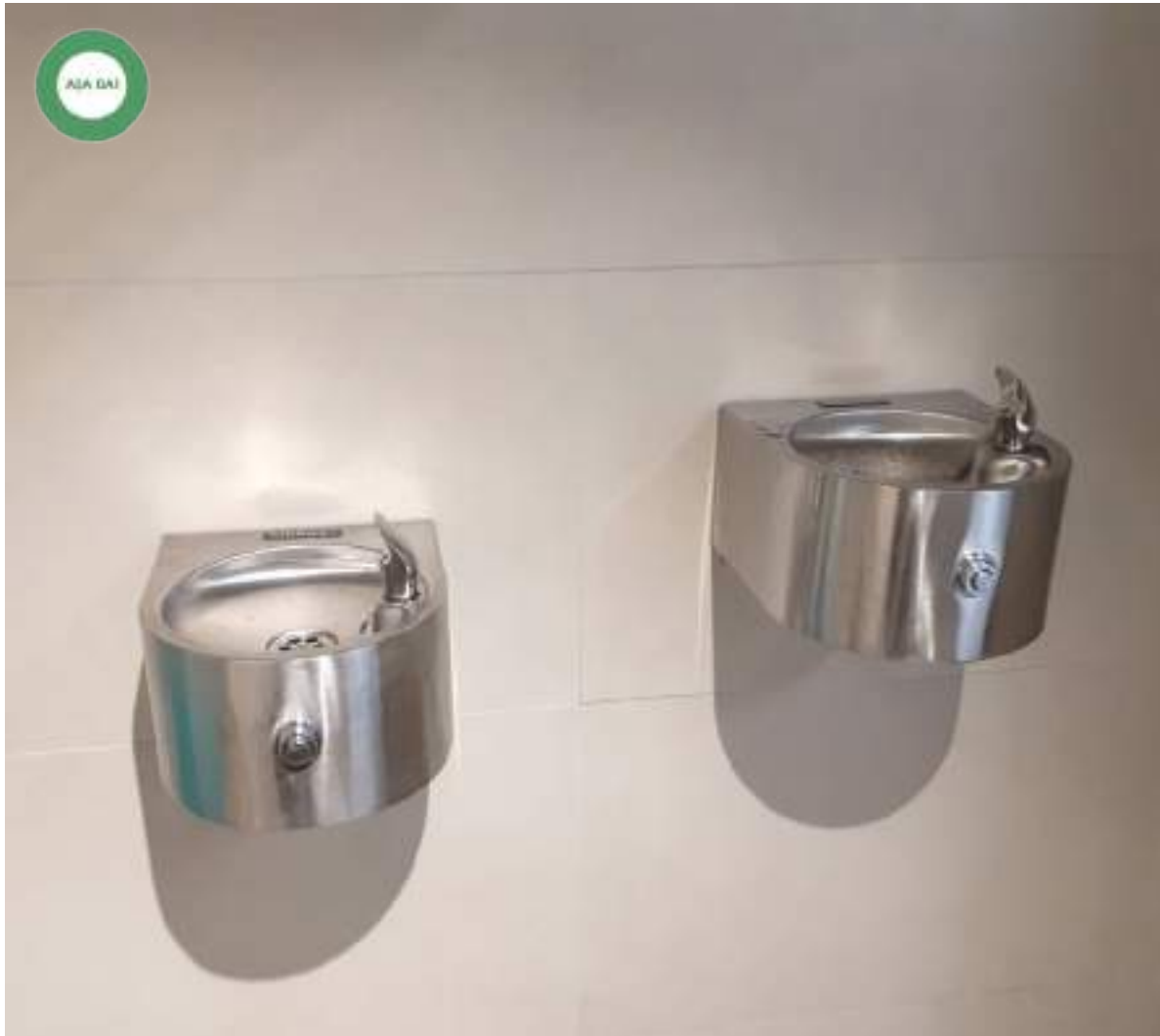
Figură 100 Așa da! Odată cu construirea de grupuri sanitare interioare, școlile pot fi echipate și cu țâșnitori, pentru un consum de apă igienic și rațional. În imagine, țâșnitori școlare, amplasate la înălțimi diferite, pentru diferite categorii de vârstă ale elevilor, inclusiv pentru uzul elevilor cu dizabilități.
