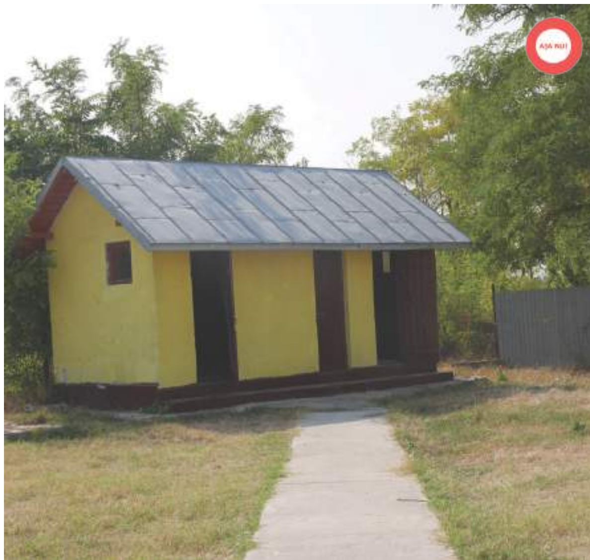
Figură 22 Așa nu! Situație foarte frecvent întâlnită la școlile din mediul rural. Pavilion separat, „în fundul curții”, pentru grupuri sanitare.
