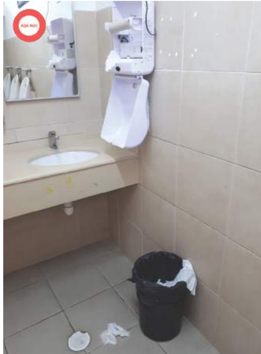
Figură 25 Așa nu! grup sanitar murdar și rău întreținut, care generează o proastă utilizare și încurajează comportamentul necivilizat.
