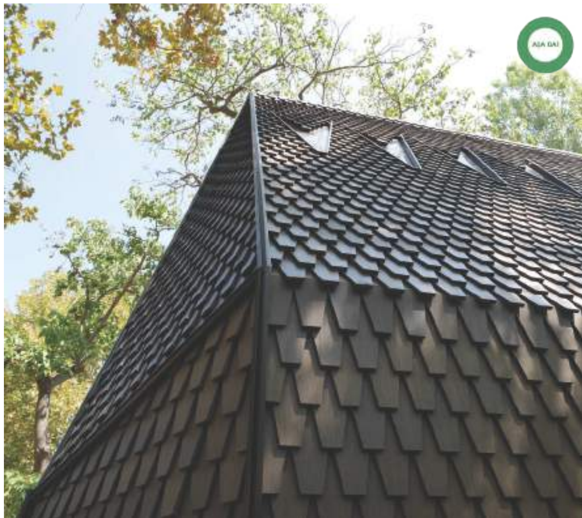
Figură 56 Așa da! Acoperiș contemporan din șindrile lemnoase.
