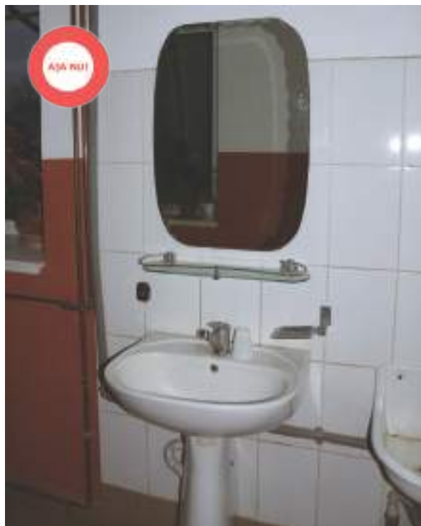
Figură 105 Așa nu! Execuție neglijentă, cu materiale de calitate neadecvată uzului școlar.
