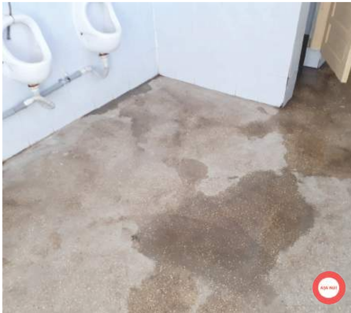
Figură 95 Așa nu! Este evident că imaginea de mai sus se datorează unui management defectuos al apei, unor defecțiuni neremediate la timp. Totuși, nici nu mai contează dacă lichidul de pe jos este apă sau altceva. Pe zone întregi ale pardoselii nu se poate călca, iar grupurile sanitare nu vor fi utilizate corespunzător.
