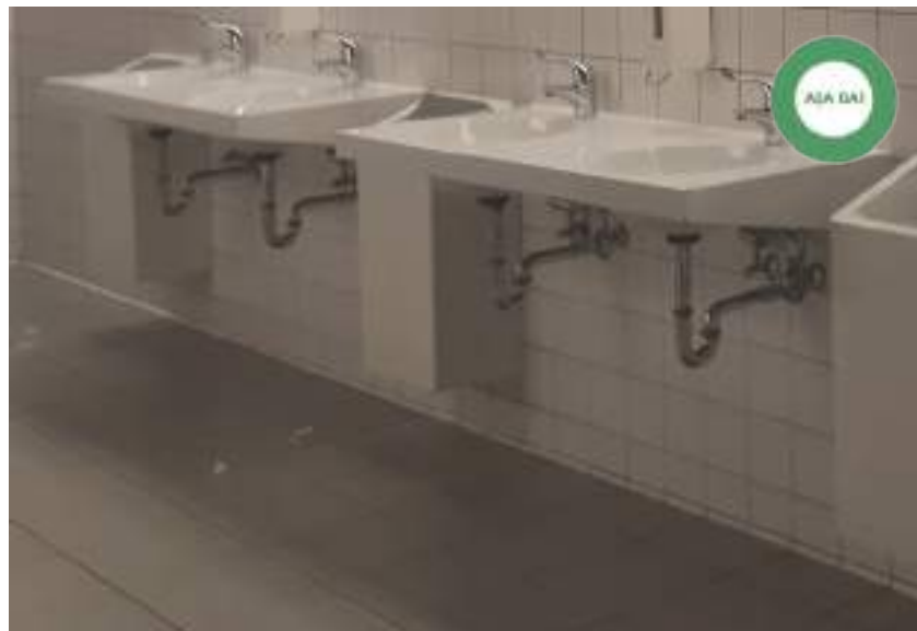
Figură 71 Așa da! Instalații de bună calitate, prin care se evită pierderile de apă.
