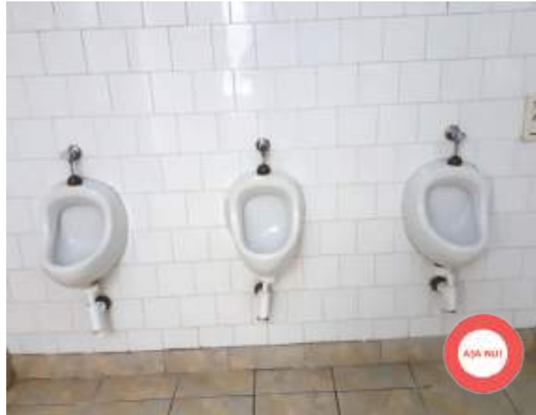
Figură 30 Așa nu! Pisoare montate fără separatoare, generatoare de lipsă de intimitate și protecție. Instalații de proastă calitate, finisaje precar executate.
