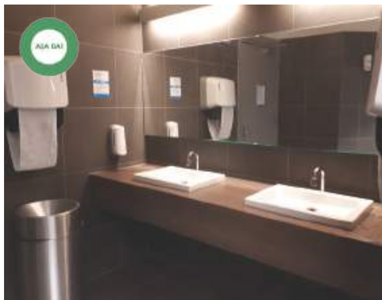
Figură 64 Așa da! Blat din material lemnos, cu lavoare din porțelan aplicate pe blat.
