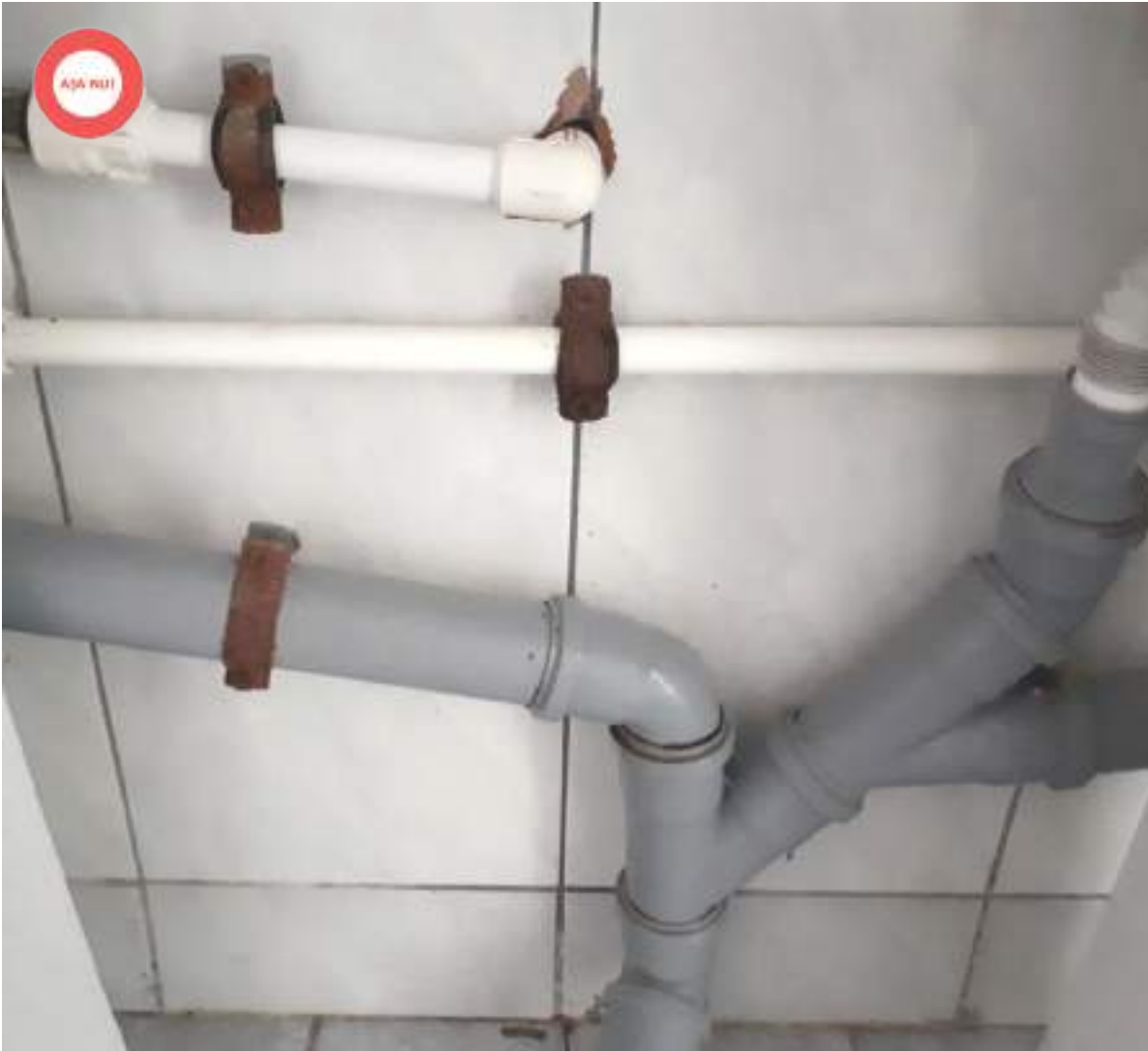
Figură 46 Așa nu! Pozare a instalațiilor după placarea peretelui cu faianță. Lucrările trebuie realizate în ordinea firească.
