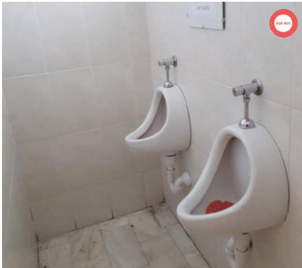
Figură 6 Așa nu! Amenajare nouă de grupuri sanitare, greșită prin dimensionarea insuficientă a spațiului pentru pisoare. Acestea nu pot fi folosite în același timp, utilizatorul din plan îndepărtat neputând să treacă pe lângă cel din plan apropiat. Se observă și prezența sifoanelor din mase plastice, lipsite de durabilitate.
