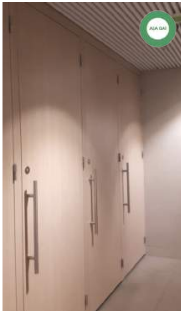
Figură 8 Așa da! Cabinetele au pereții până în tavan, asigurând corespunzător intimitatea necesară copiilor.
