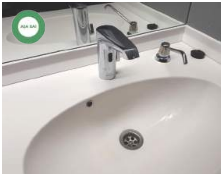
Figură 63 Așa da! Blat turnat, racordat la perete prin elemente de tip plintă. Bateria este echipată cu fotocelulă, iar dispenserul de săpun bine plasat.
