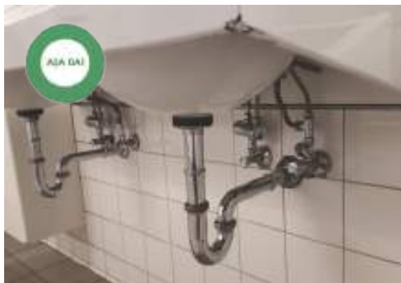
Figură 72 Așa da! Rezolvare a evacuării apelor uzate cu fittinguri de calitate, durabile, din oțel inoxidabil, ușor de întreținut și cu durată mare de viață.
