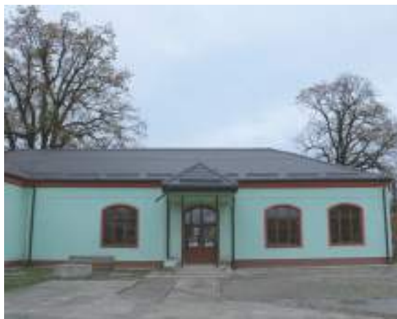
Figură 106 Școală veche, din mediul rural. Chiar dacă a fost reabilitată termic, construcția trebuie expertizată în contextul alipirii unei extinderi cu grupuri sanitare.
