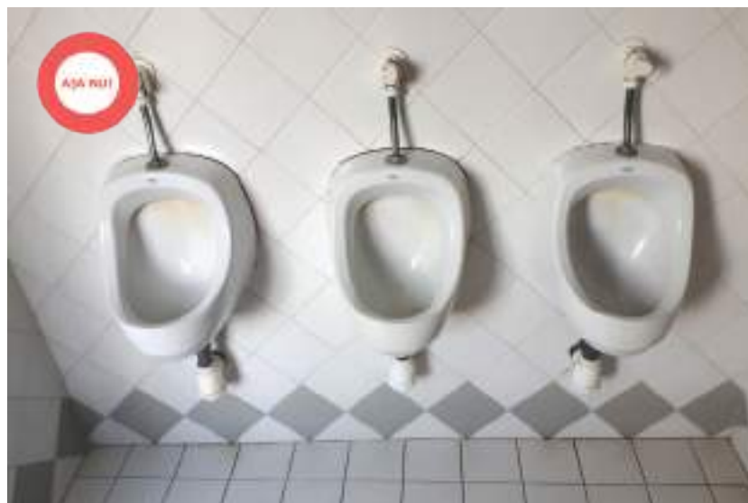
Figură 99 Așa nu! Distanțele prea mici între pisoare generează imposibilitatea utilizării concomitente. Aproximarea prea mare generează expunere la mirosuri neplăcute.
