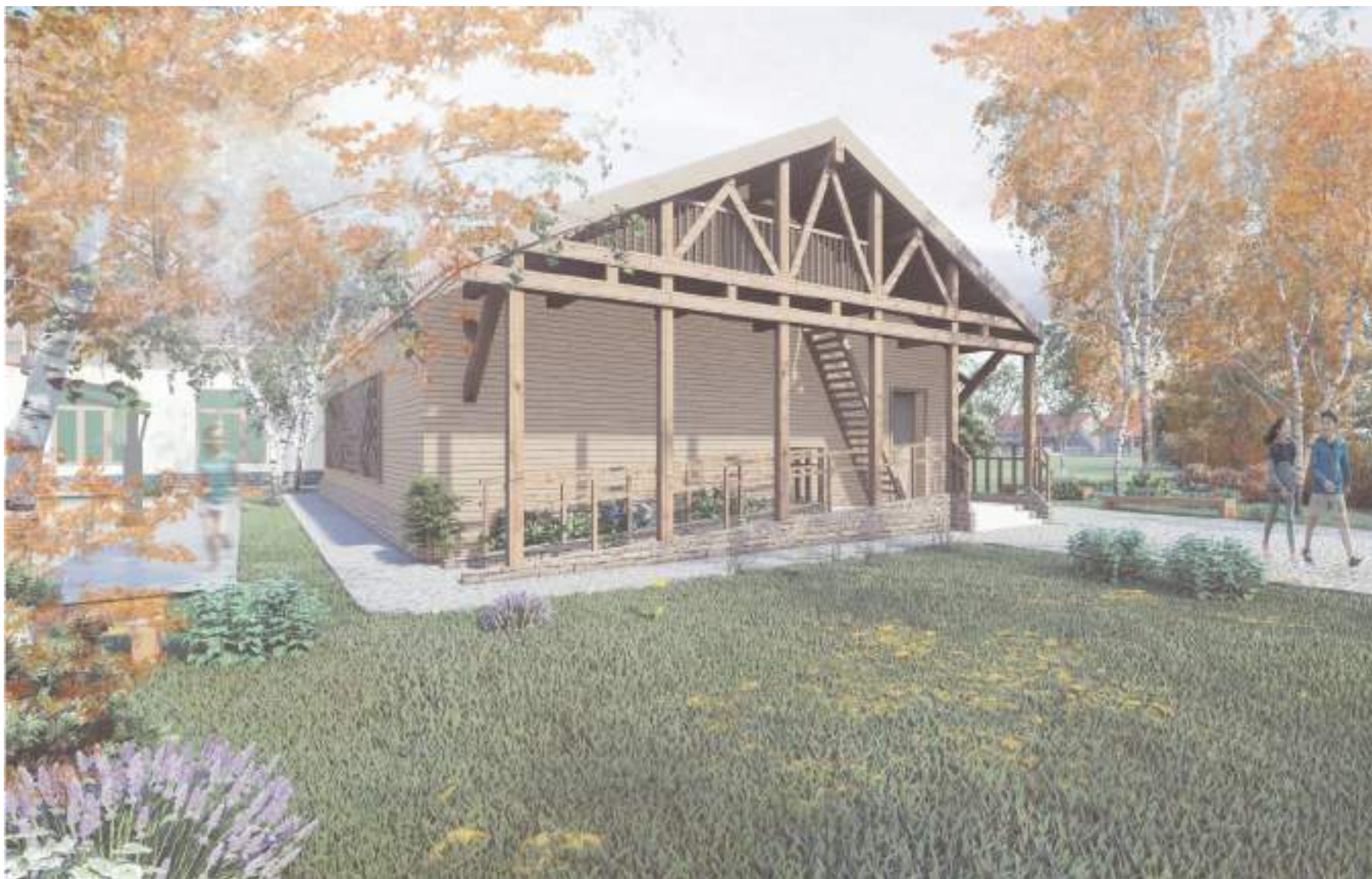
Figură 113 Structură ușoară și panouri sandwich. Perspectivă la nivelul ochiului.
