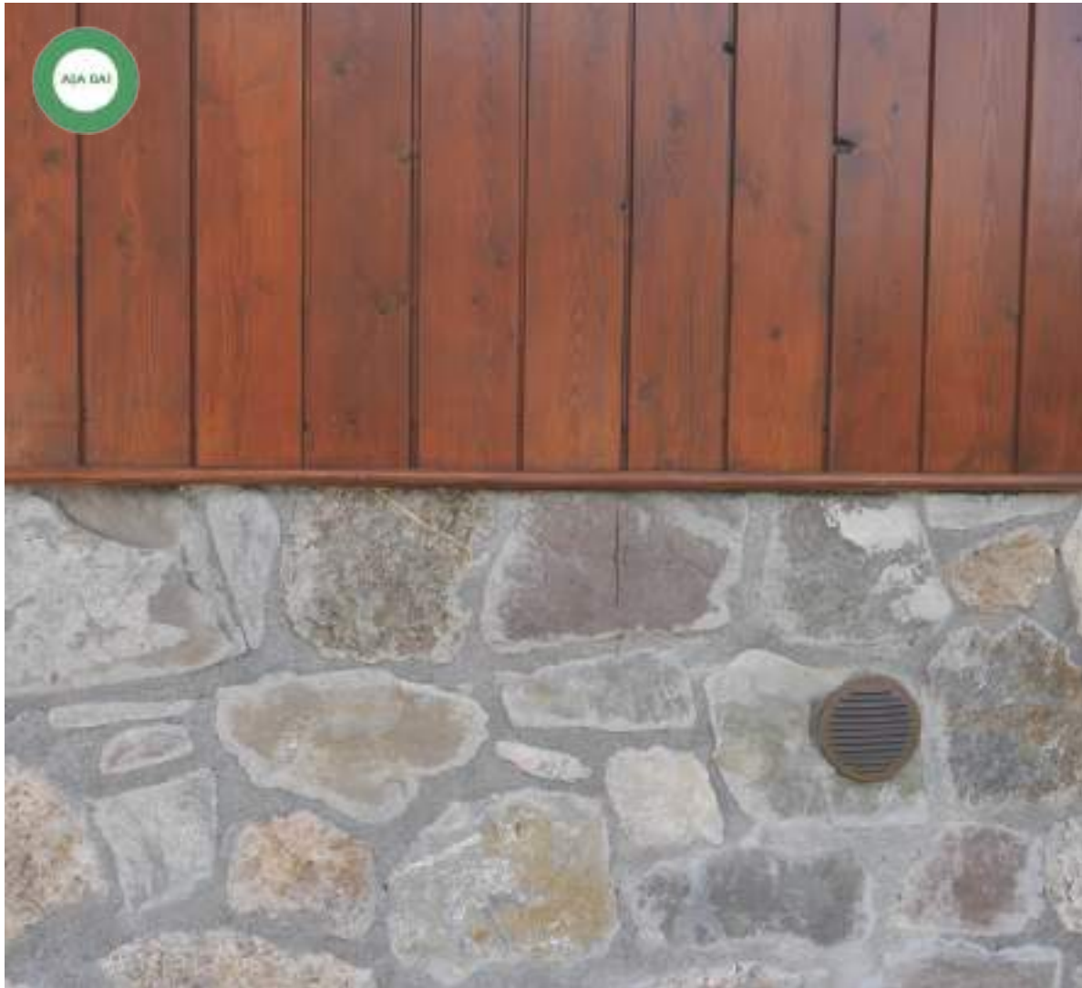
Figură 50 Așa da! Rezolvare corectă a relației dintre un soclu și un finisaj perietal, ambele de proveniență locală.
