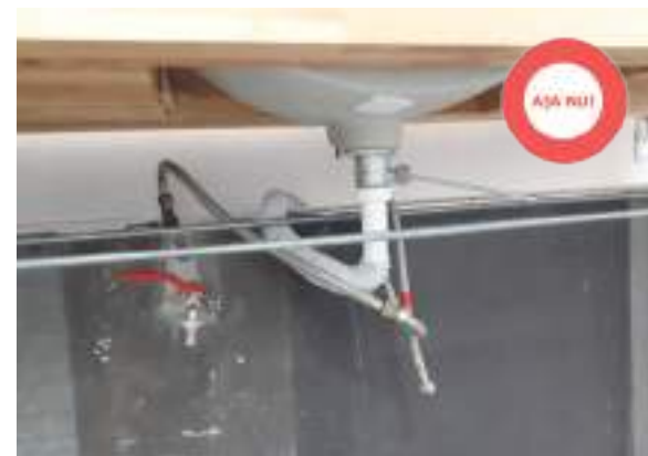
Figură 73 Așa nu! Se vor evita instalațiile sanitare cu racorduri aparente flexibile, deoarece acestea sunt predispuse la a fi scoase din poziție, și se vor utiliza racorduri metalice fixe.
