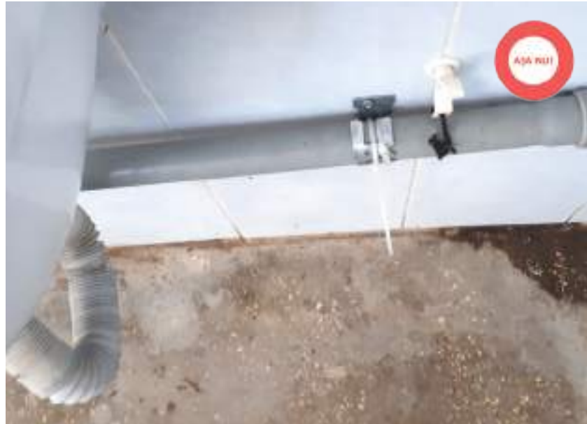
Figură 70 Așa nu! Instalațiile precare, folosind soluții de uz casnic, sunt responsabile pentru pierderi însemnate de apă, ceea ce conduce la disconfort în utilizare, mirosuri ș.a.m.d., pe lângă creșterea cheltuielilor de exploatare.
