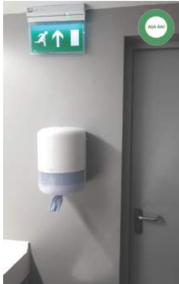
Figură 66 Iluminatul de siguranță, în vederea evacuării, este obligatoriu la grupurile sanitare școlare. Acestea sunt ansambluri de încăperi cu multe uși și, în cazul unei avarii a sistemului de iluminat general al clădirii, orientarea poate deveni dificilă pe timp de noapte. În caz de seism sau incendiu, se poate instala panica.
