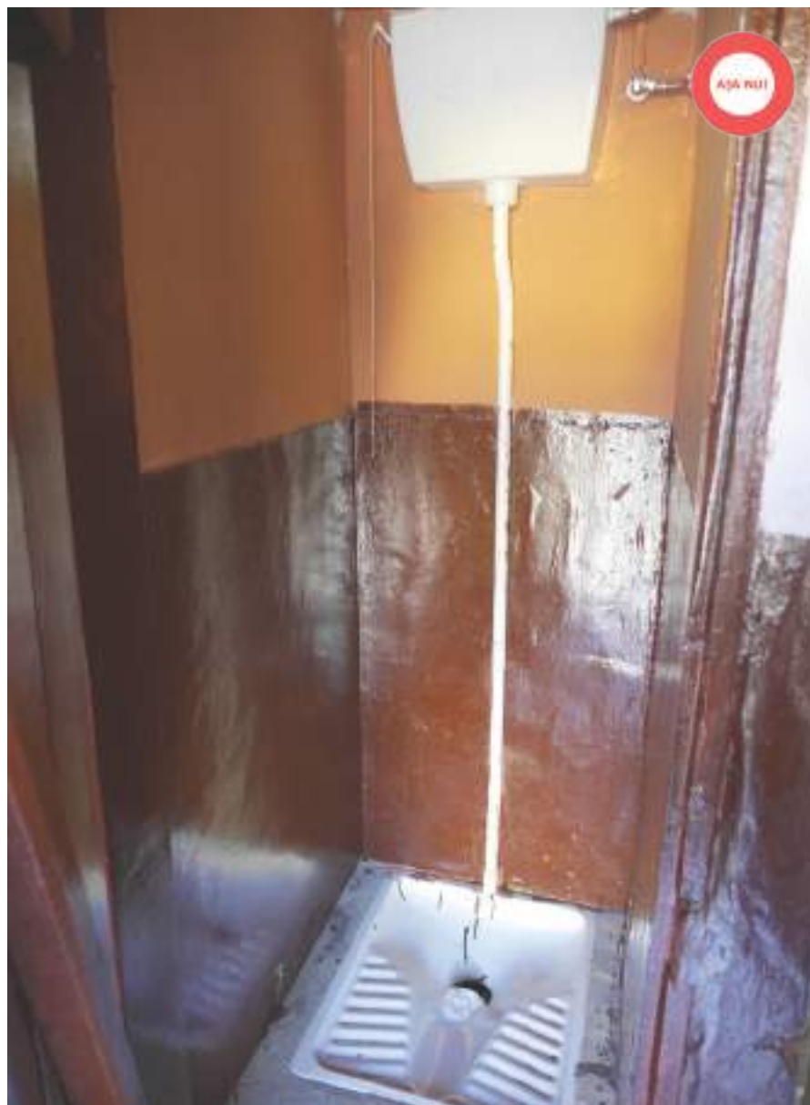
Figură 24 Așa nu! Grup sanitar exterior vopsit în culori care fac foarte dificilă curățenia și dezinfectarea spațiului.
