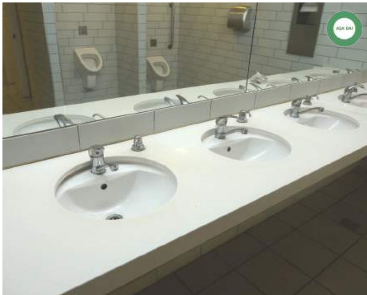
Figură 13 Așa da! Rezolvare a lavoarelor cu blat unificator, în care este amplasat dispenserul de săpun. În oglinda de dimensiuni generoase se observă pisoarele, separate unul de celălalt prin perete continuu.
